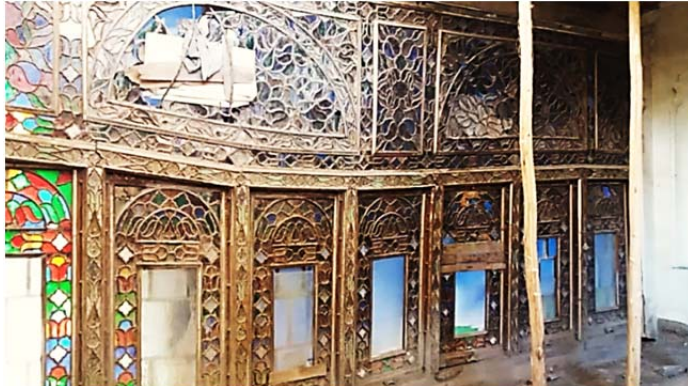
تصویر ۴: نمای ارسی خانه خلیل‌زاده قبل از مرمت، به دلیل افتادن بخشی از بار ساختمان روی تیر بالایی ارسی، بخش پیشانی آن درهم فشرده شده بوده است (تصویر از آقای محبوب نوعی اقدام)
