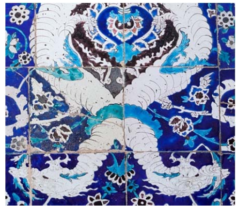
تصویر ۱: قاب کاشی هفت‌رنگ با نقش ازدها بر ایوان غربی صحن عتیق (آرشیو مرکز آفرینش‌های هنری آستان قدس)
