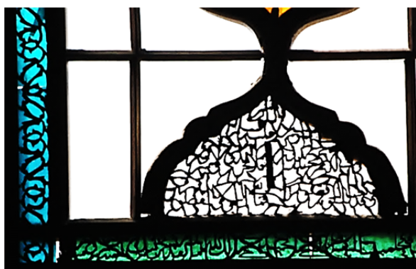
تصویر ۱: شیوه پارچه‌بری چوبی روی شیشه‌آبی فیروزه‌ای با طرح اسلیمی سرهم سوار و پارچه‌بری بخشی از سوره قدر روی شیشه‌سبز در اطراف قاب مرکزی و شبکه‌بری آیات قرآنی در زیر قندیل میانی لنگه‌های ارسی خانه ابراهیمی (نگارندگان)
