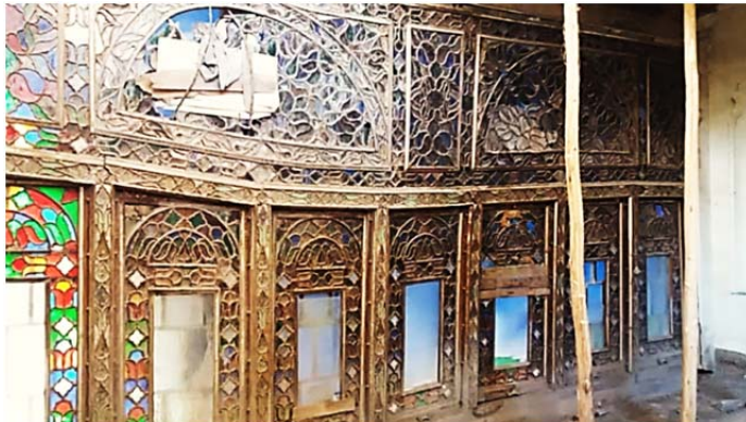
تصویر ۴: نمای ارسی خانه خلیل‌زاده قبل از مرمت، به دلیل افتادن بخشی از بار ساختمان روی تیر بالایی ارسی، بخش پیشانی آن درهم فشرده شده بوده است (تصویر از آقای محبوب نوعی اقدام)
